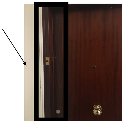
PLAQUES MÉTALLIQUES TOUTE HAUTEUR NON CONFORMES
