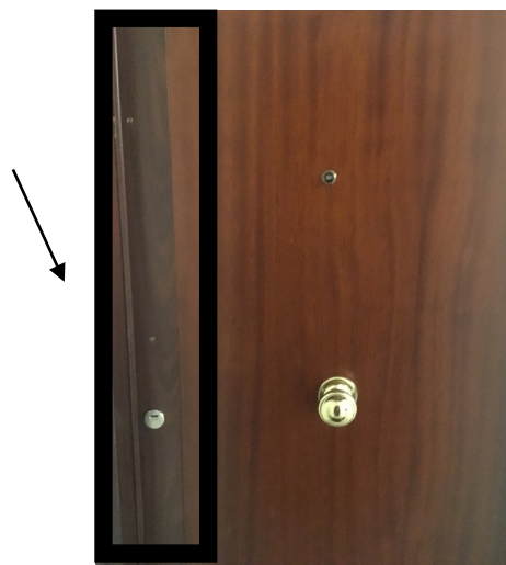
PLAQUES MÉTALLIQUES TOUTE HAUTEUR NON CONFORMES
