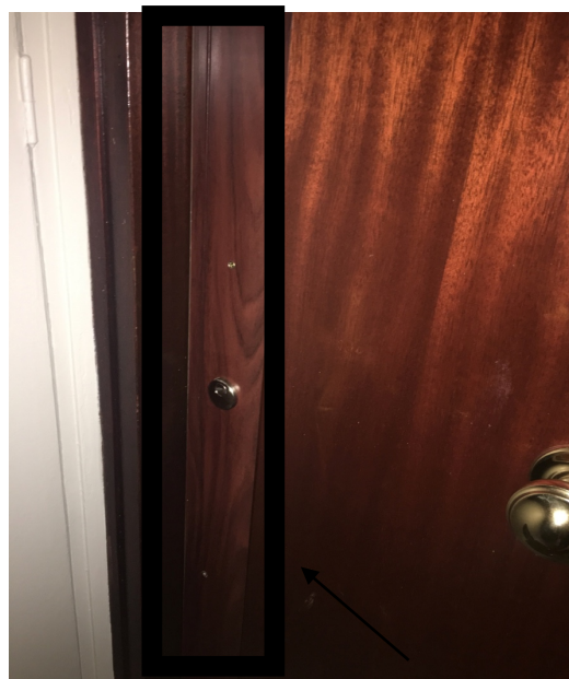
PLAQUES MÉTALLIQUES TOUTE HAUTEUR NON CONFORMES
