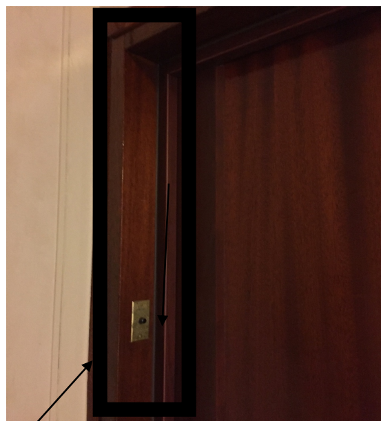
PLAQUES MÉTALLIQUES TOUTE HAUTEUR NON CONFORMES
