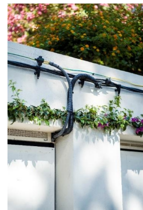
Linteau percé permettant le passage de la gaine électrique
