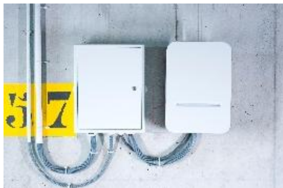
Armoire électrique (à gauche) et borne de recharge (à droite)
