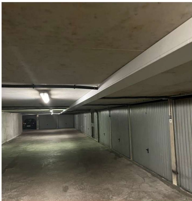
Une goulotte inversée fixée au plafond pour recevoir le câble BT. Largeur : 150, 200 ou 300 mm, hauteur : 100 mm
