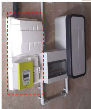
Installation minimale pour un box fermé, et maintenu fermé même en l'absence du véhicule
