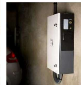
Coffret électrique incluant la borne de recharge,
