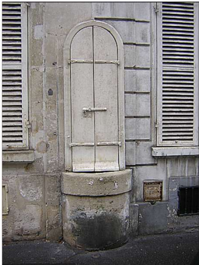
Pompe à coffrage de bois, 36, rue de Seine, VI e arrt. La nappe étant partout présente à faible profondeur
