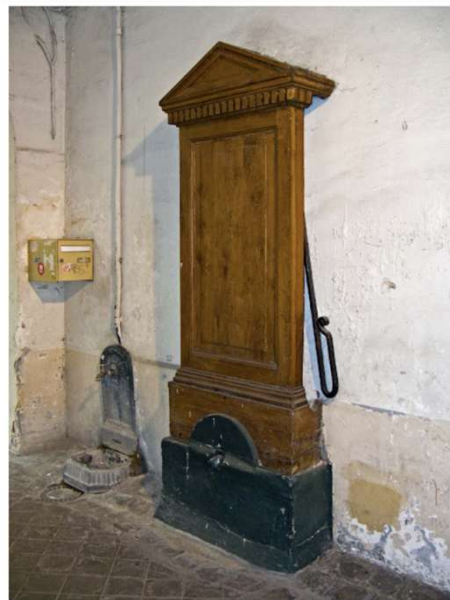
Pompe à coffrage de bois, 36, rue de Seine, VI e arrt. La nappe étant partout présente à faible profondeur
