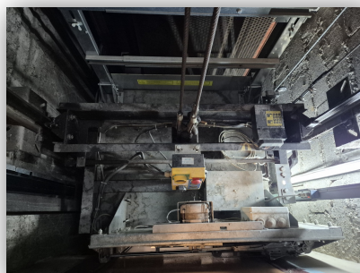
Toit de cabine
