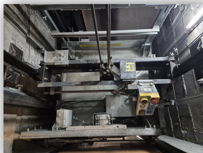
Toit de cabine
