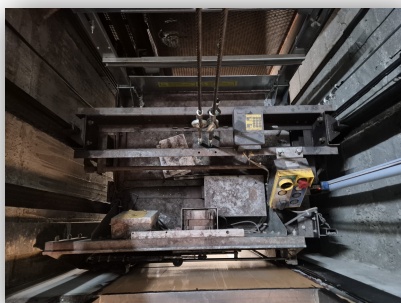
Toit de cabine
