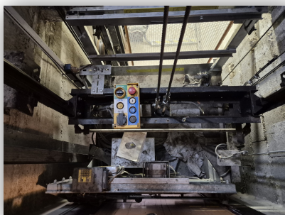
Toit de cabine
