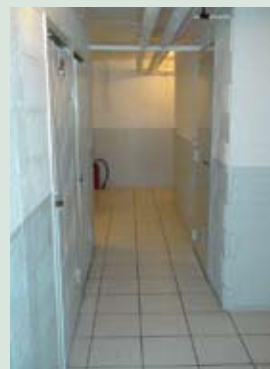
Nouveau carrelage et nouvelle peinture pour certaines caves
