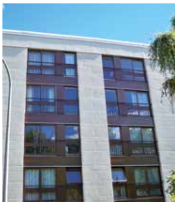
Façade non décapée
