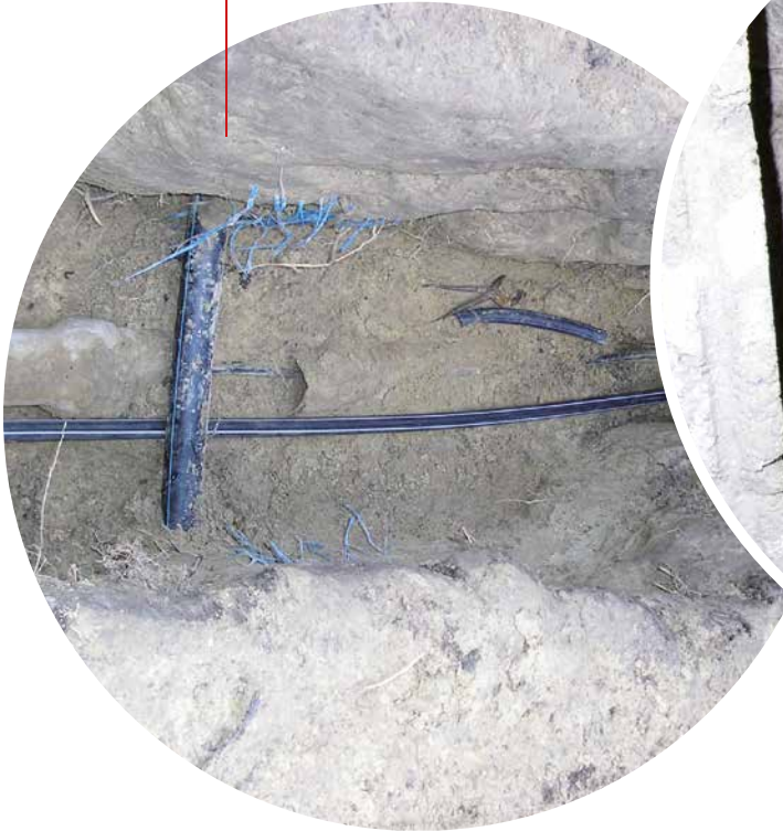
TRAVAUX SUR LES CANALISATIONS EXTÉRIEURES D'ALIMENTATION DES IMMEUBLES
