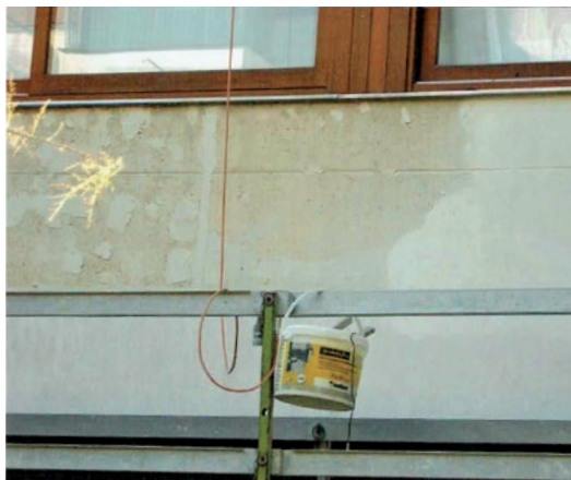
► Opération de réfection de trumeaux en pierre
