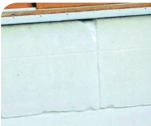
► Réfection de joint de pierre
