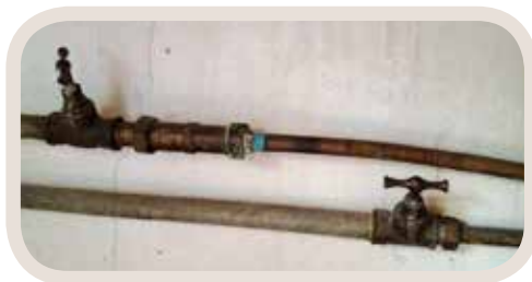
Robinetts AVANT remplacement
