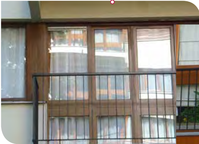
Avant le décapage
