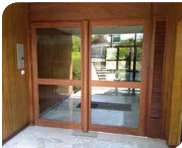
Isolation hall + rénovation bois
